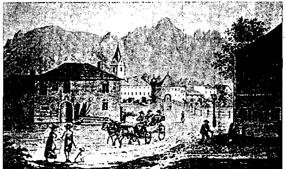
Abb. 1. Alt Lienz: neue Brücke mit Spitalstor, abgerissen 1840
