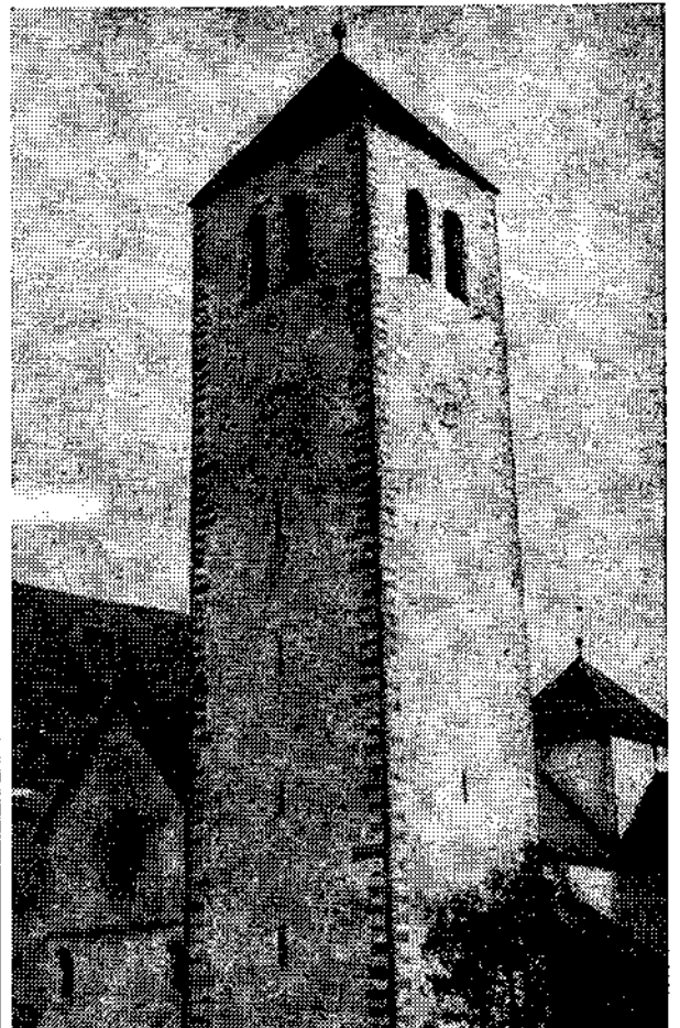
Der Turm wartet noch auf Renovierung
