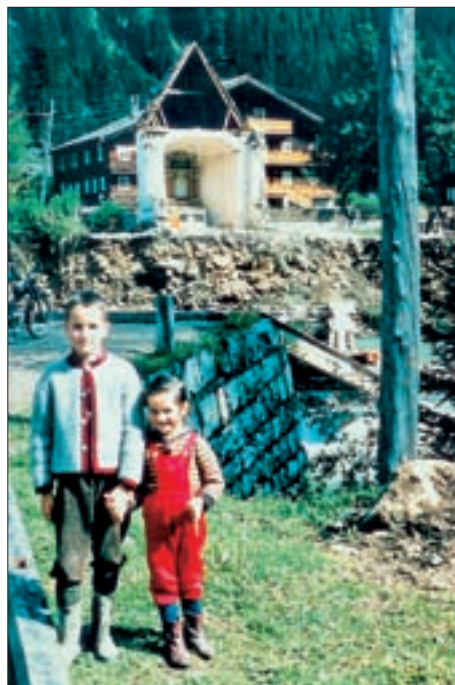
Das zerstörte Brugger Kirchlein.
